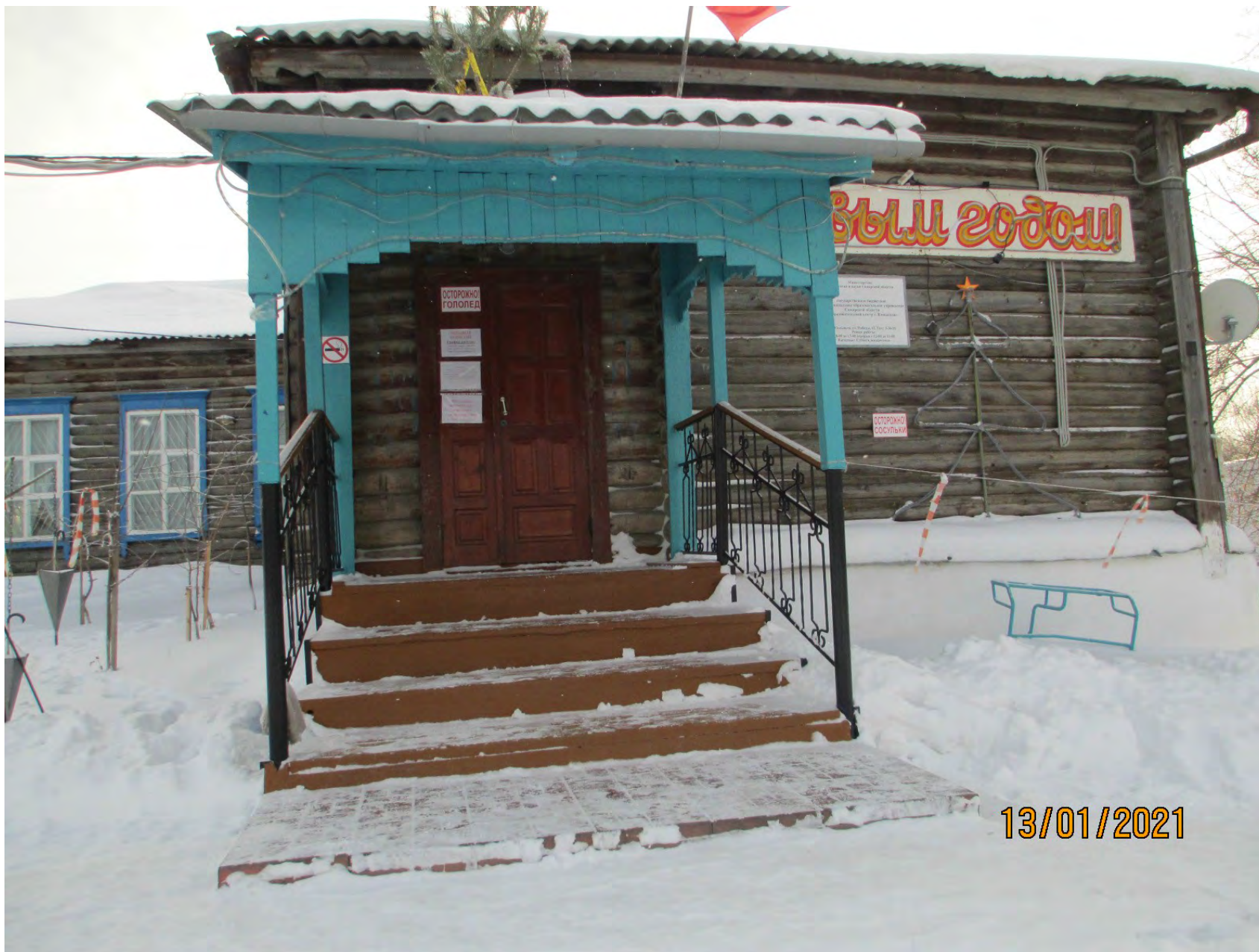
Фото №7 ( Входная лестница в ОУ)
