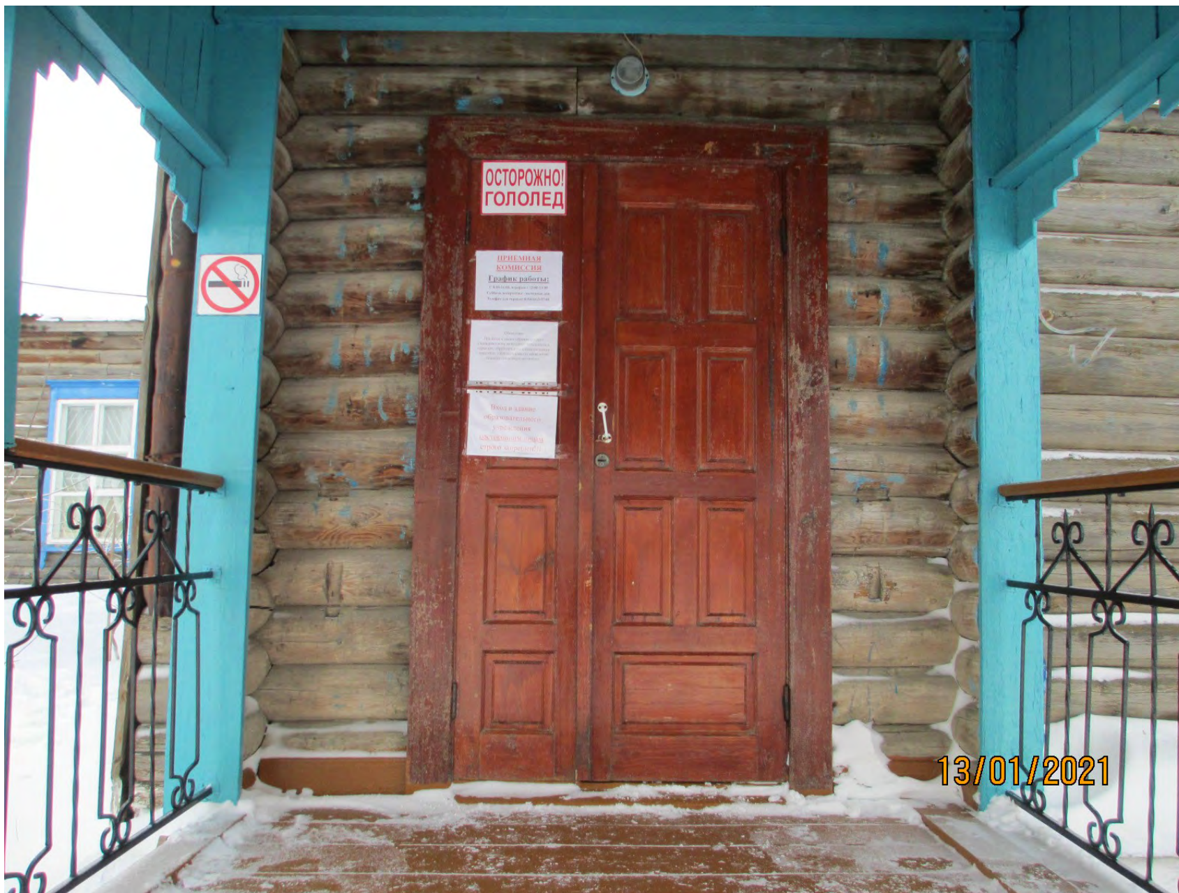
Фото №10 (Входная дверь.)
