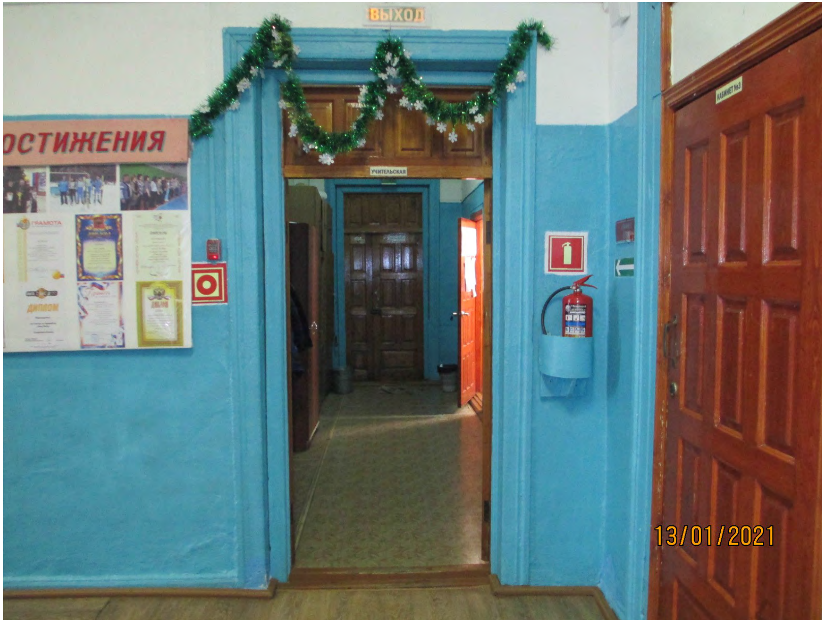
Фото №14 ( Дверь к запасному выходу)
