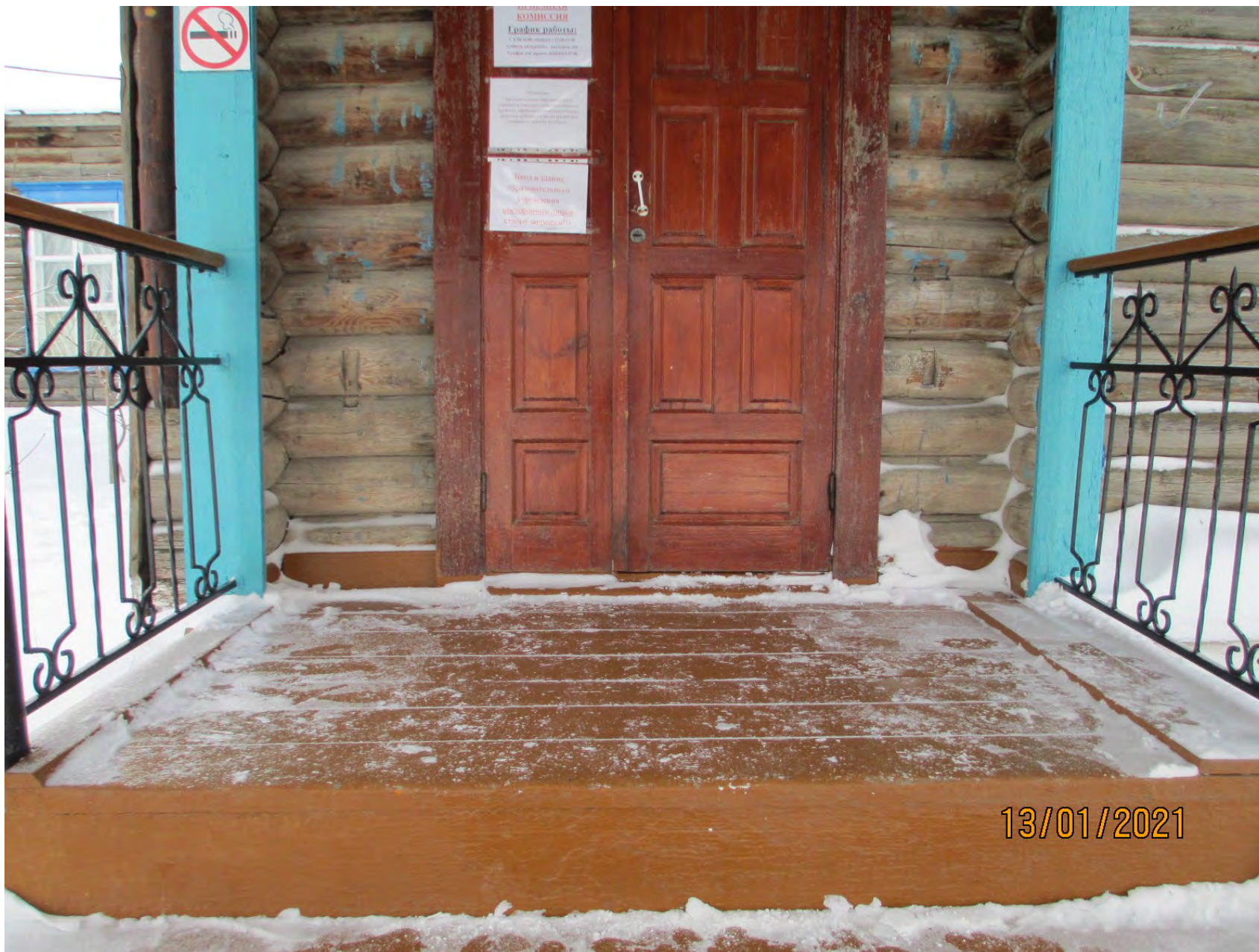
Фото №9( Входная площадка)
