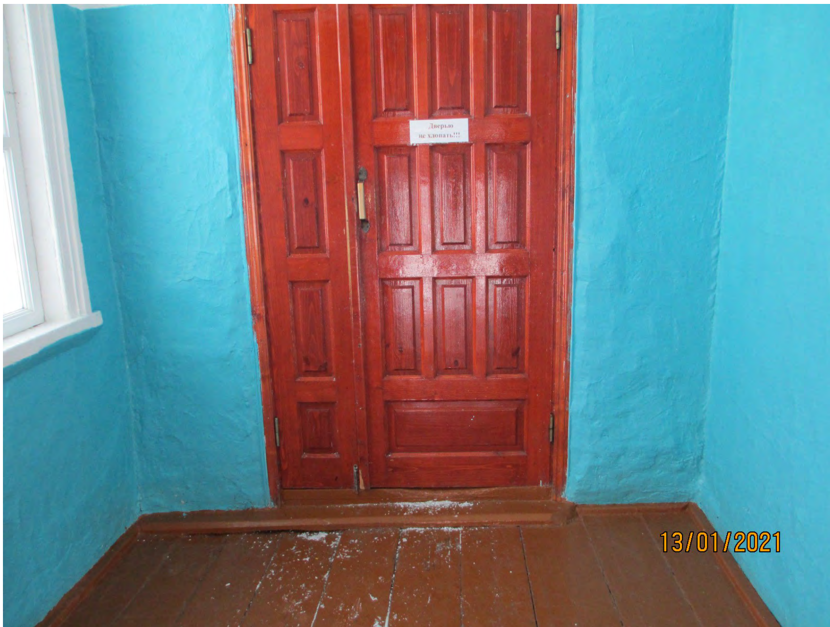
Фото №11( Тамбур входная)
