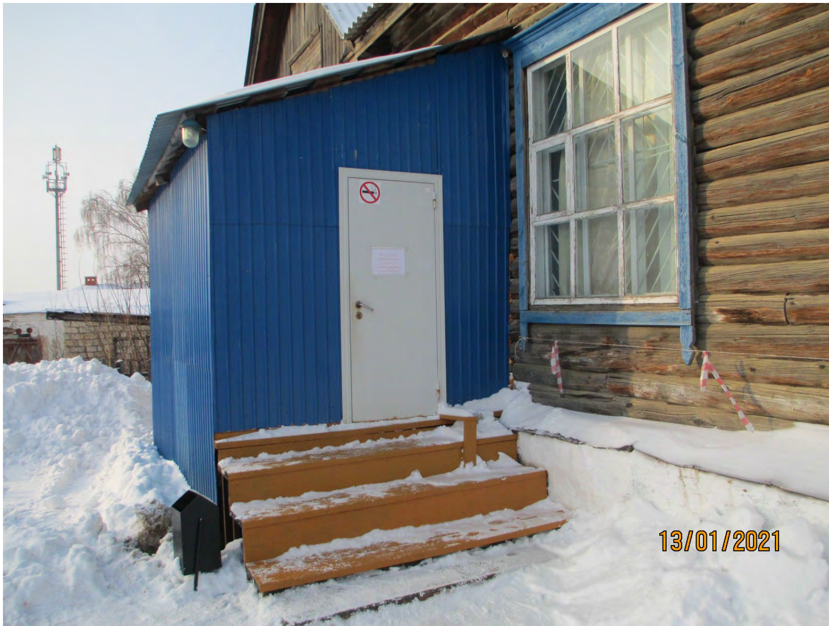
Фото №16 (Крыльцо Запасного выхода)
