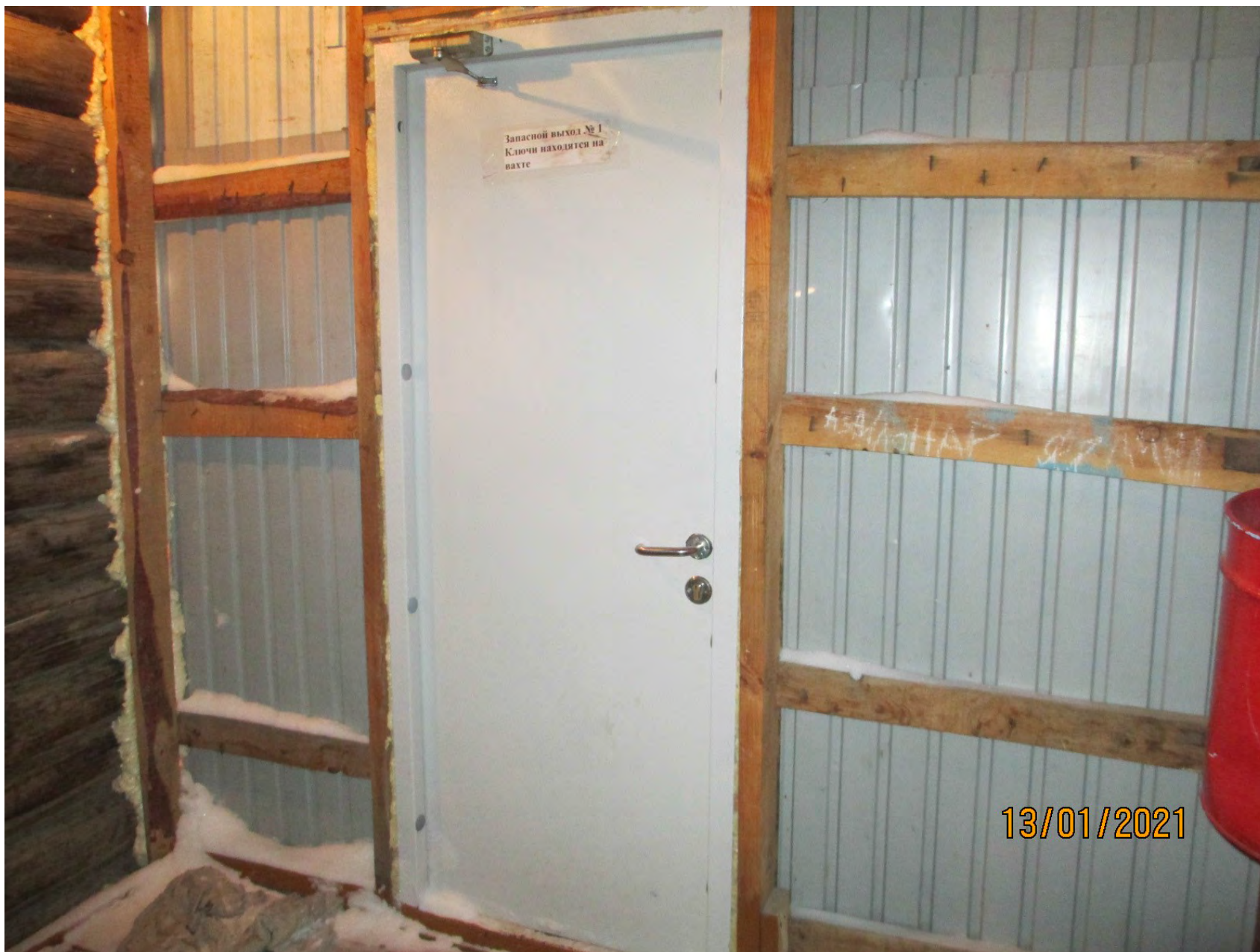
Фото №15 (15. Тамбур запасного выхода)
