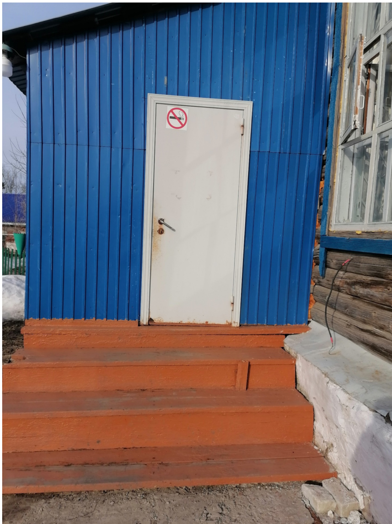
№33 Крыльцо тамбура запасного выхода
