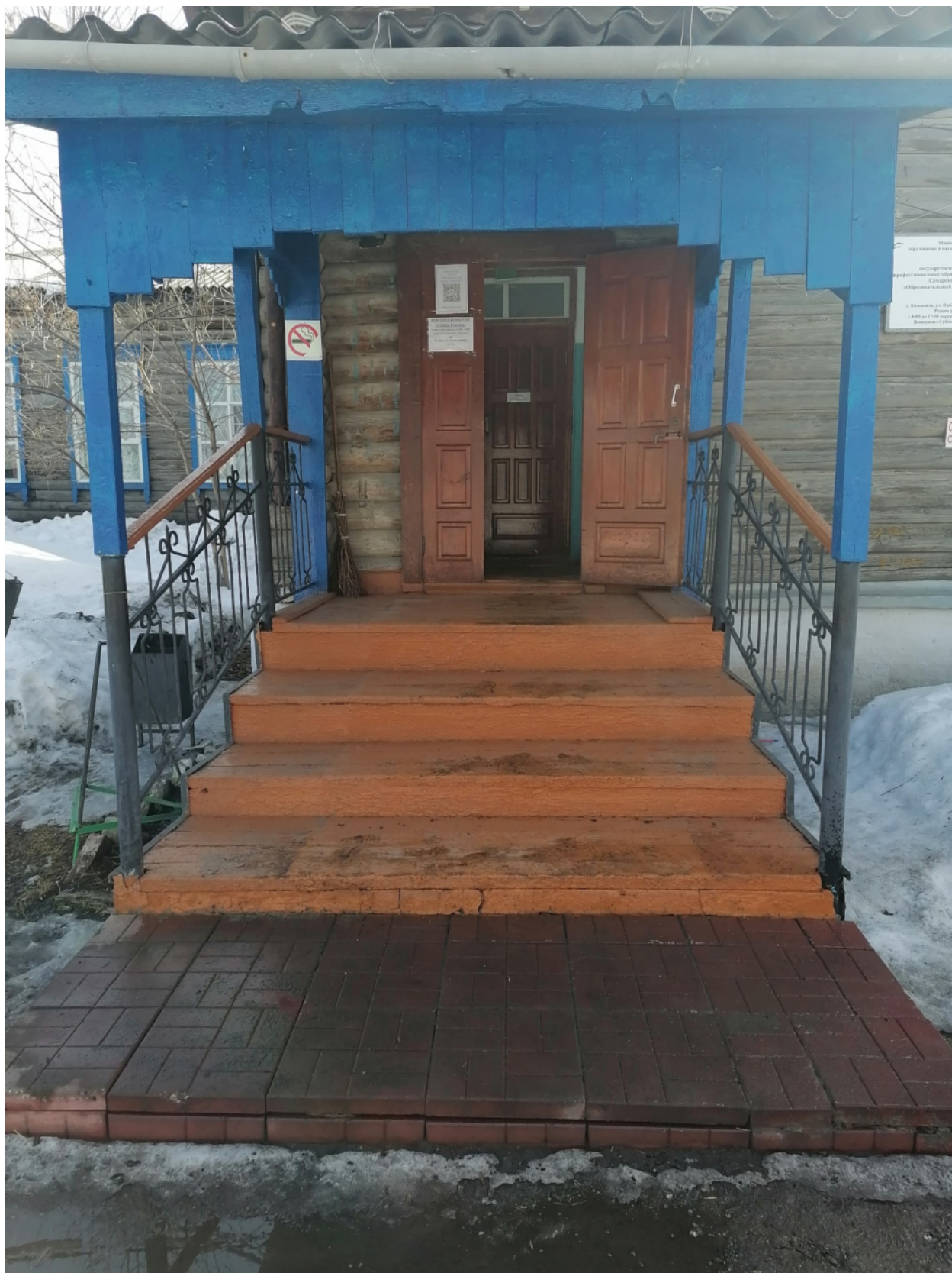
№8 Главный вход в здание (Крыльцо с лестничным маршем)
