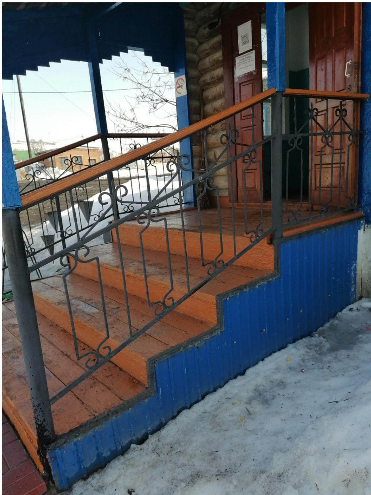
№9 Крыльцо входная площадка (Поручни с двух сторон)
