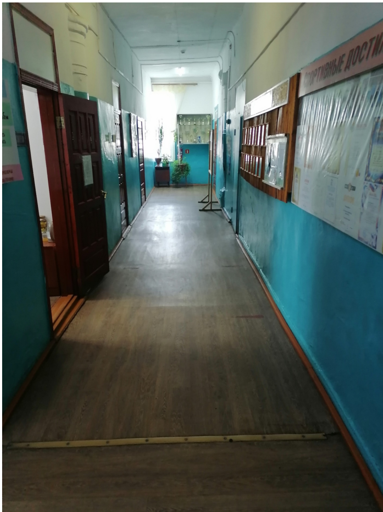
№13 Пути движения внутри здания(коридор)
