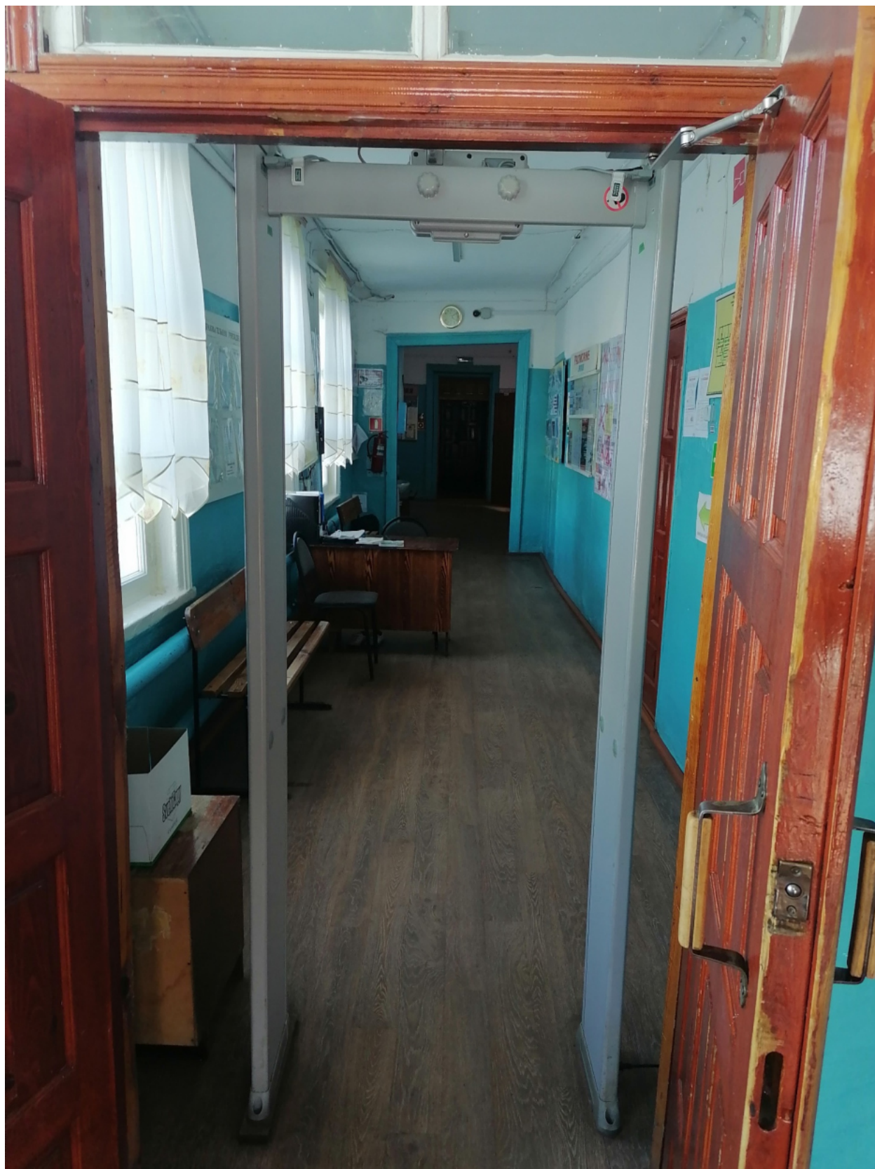
№11 Вход в здание (распашная дверь)
